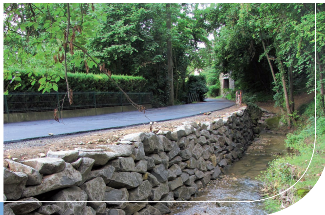
Enrochement et sécurisation du ruisseau d'Enval
