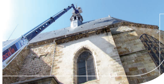
Réfection de la toiture de l'église Saint-Pierre
