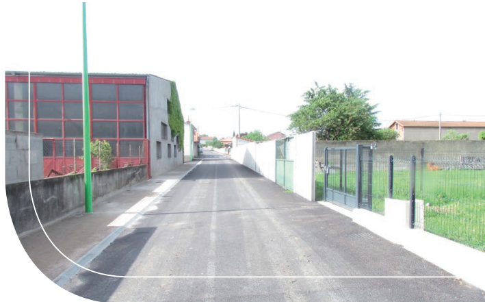
Fin des travaux de voirie rue Michel Couturier
