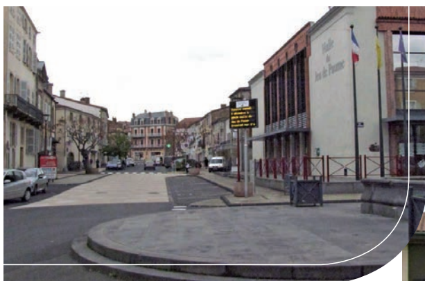
Rénovation du boulevard du Jeu de Paume
