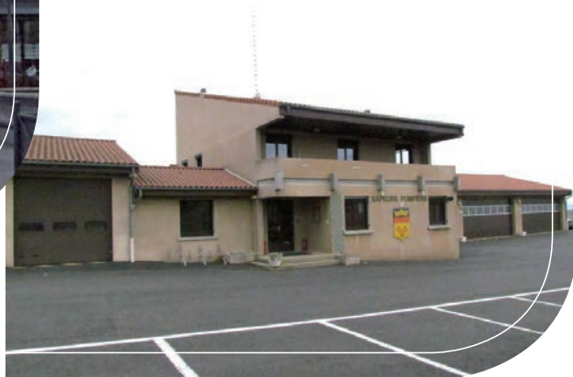
Centre de secours, caserne des sapeurs pompiers
